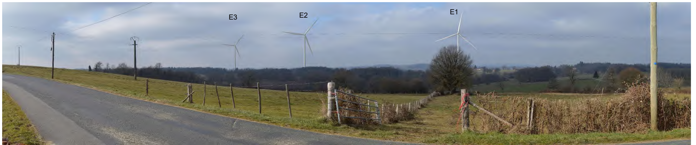
Photographie 126 : Vue en direction du projet de Fromentaux depuis la route départementale n°17 aux abords du lieu-dit Maison Neuve.
