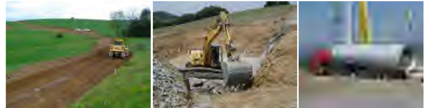
Photographie 99 : illustration d'un chantier éolien.
