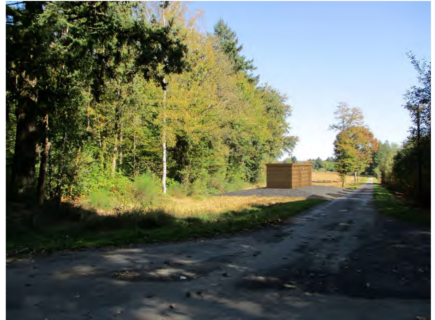
Photographie 96 : Photomontage du poste de livraison sud (source : ENGIE Green).
