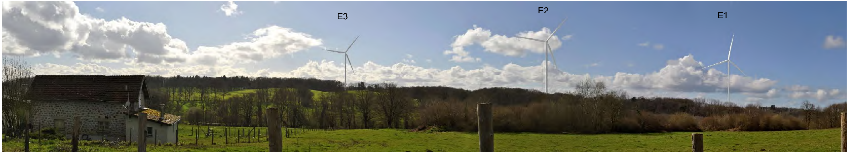
Photographie 124 : Vue en direction du projet de Fromentaux depuis le hameau Les Biez (photomontage n°25 du carnet en annexe).
