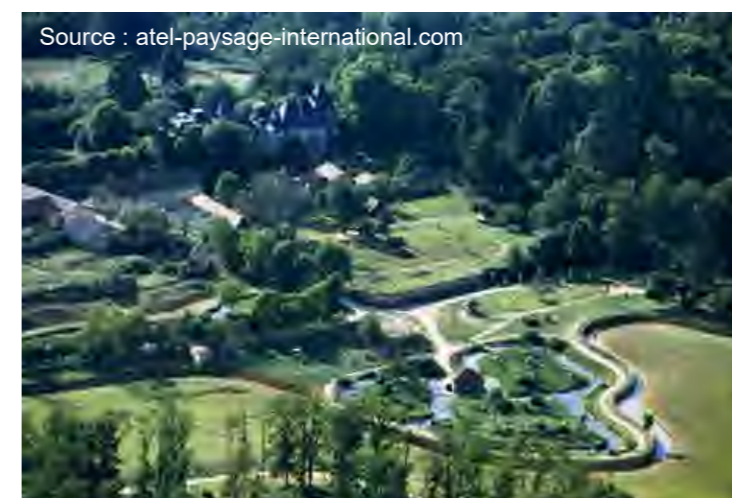
Photographie 26 : Vue aérienne sur le parc du château du Reynou.
