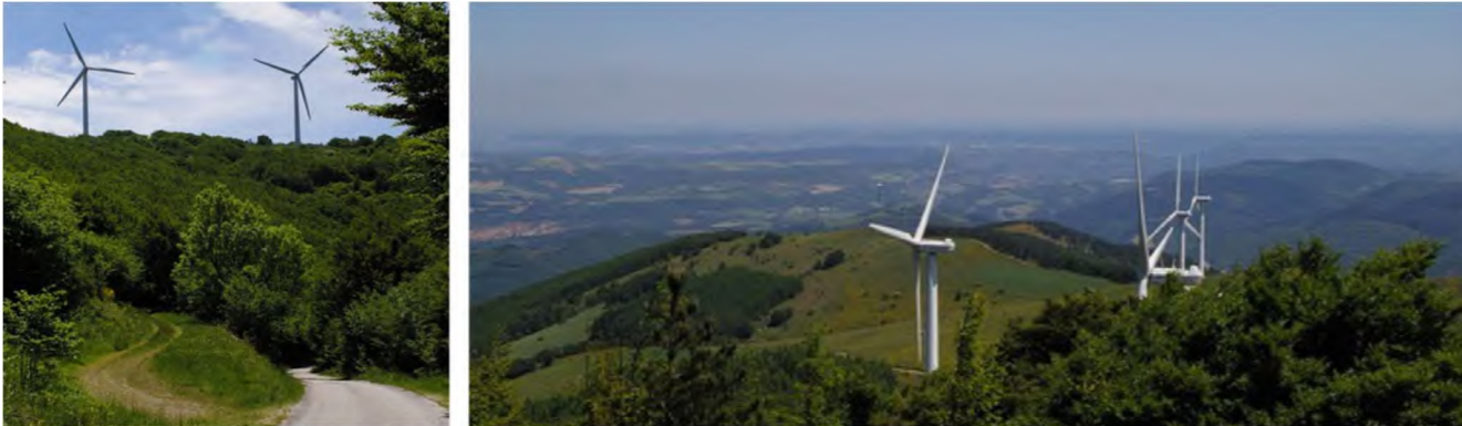
Photographie 97 : Vue en contre-plongée et vue en plongée du parc éolien de Merdélou (photo : F. Bonnenfant).
